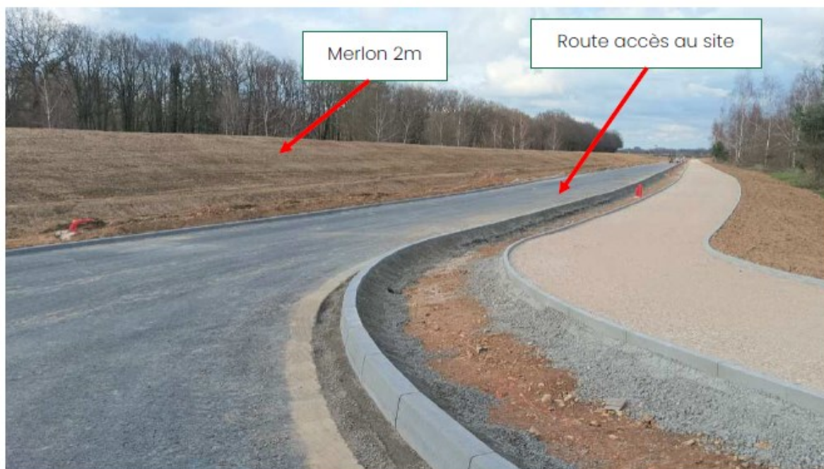
vue sur le merlon et la route d'accès au site
